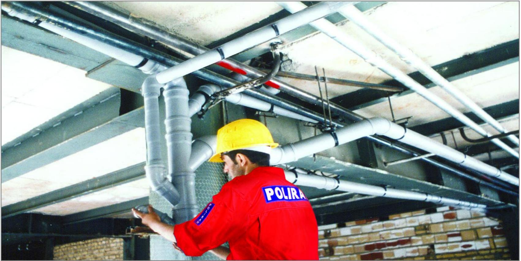
شکل شماره ۶ چگونگی قرار گرفتن لوله‌های جانبی فاضلاب و اتصال آنها به لوله قائم
